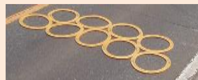
上北建設が開発した「ピタリング」 (振動で運転手に注意喚起する)
